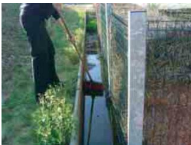
Figure 7 : Nettoyage du caniveau
