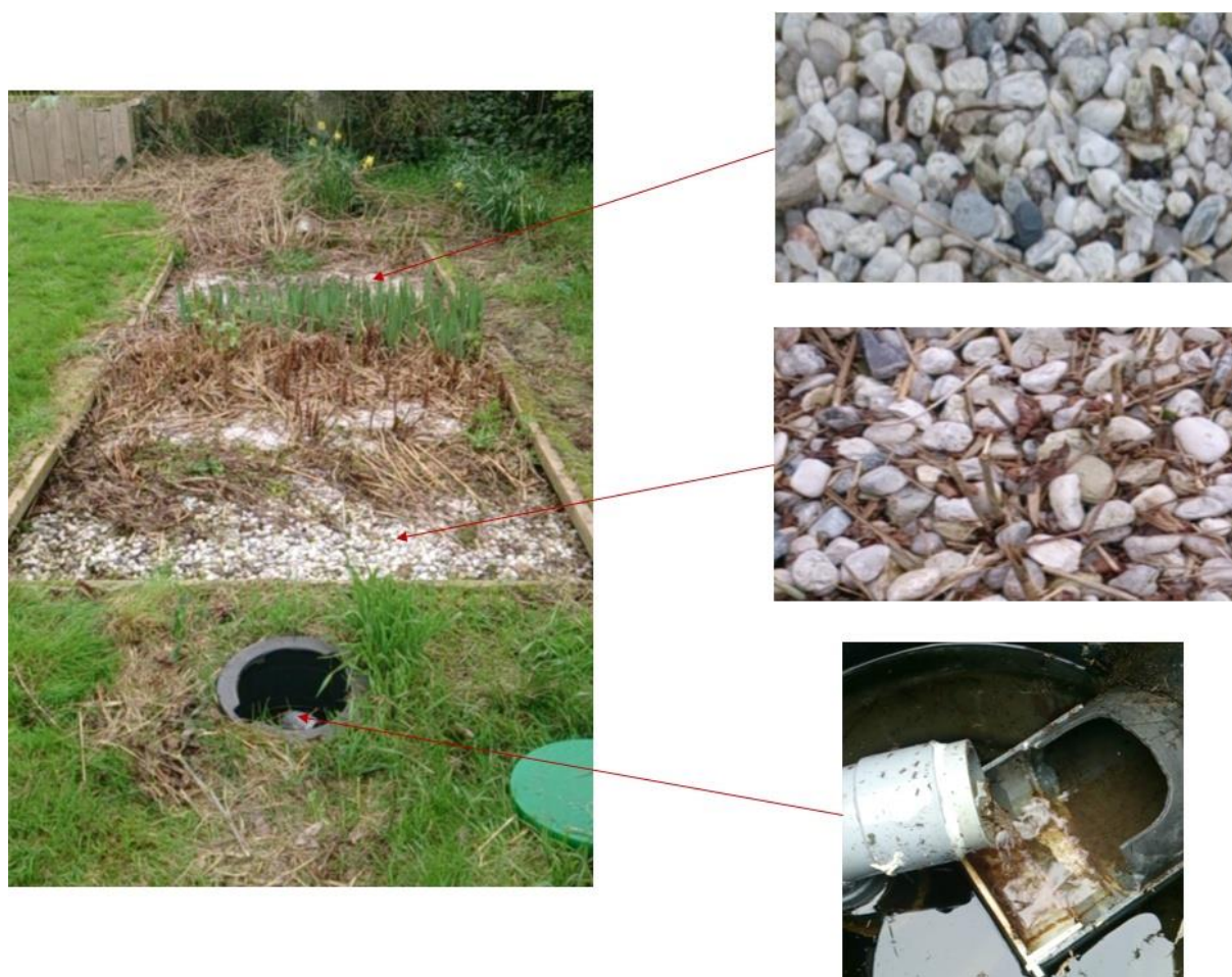
Figure 21 : Photos du 2 ème filtre
