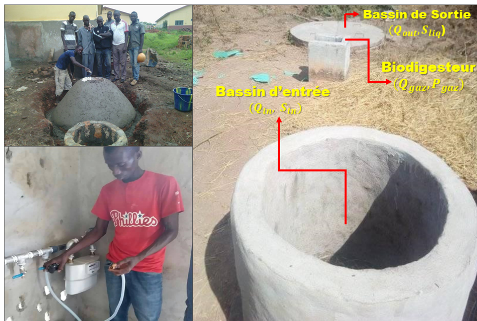
Figure 2.4 – Illustration du digesteur construit à l'IST-Mamou
